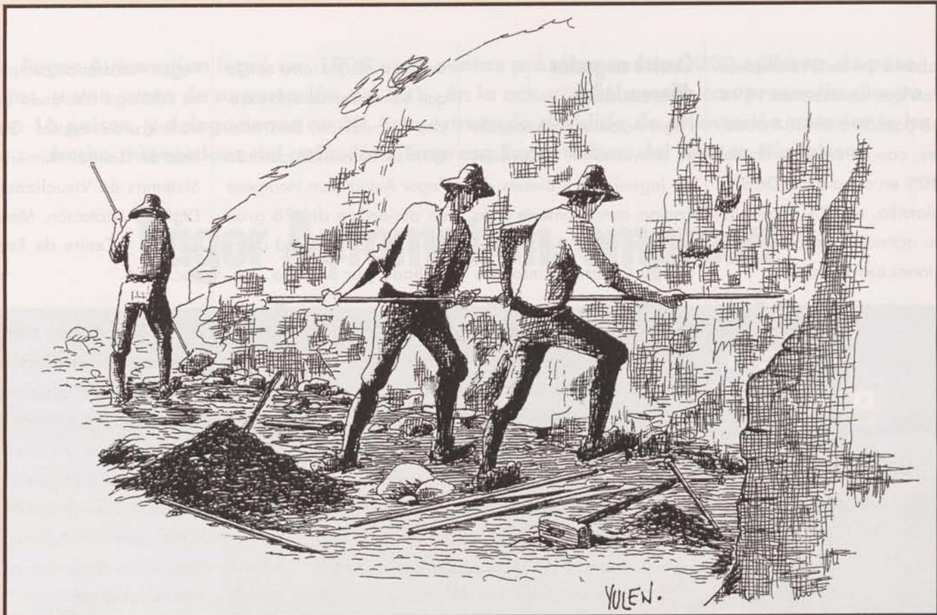
La extracción del mineral en Udala para la obtención del acero, se llevaba a cabo sobre todo a cielo abierto y utilizando únicamente palancas y otras herramientas manuales (Dibujo de Julen Zabaleta).
