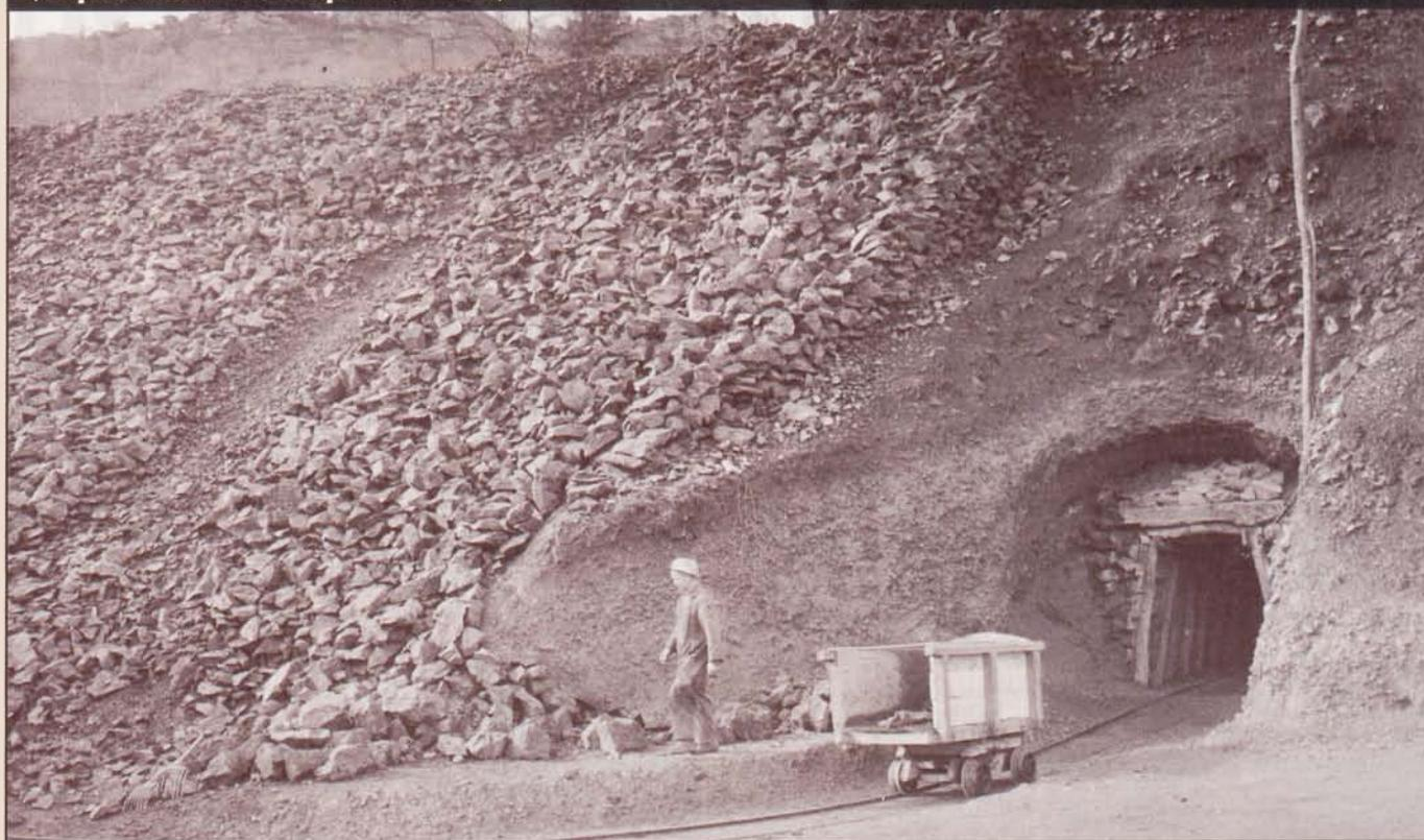
EL ASFALTO SE HA OBTENIDO TRADICIONALMENTE DE ROCAS, GENERALMENTE CALIZAS O ARENISCAS IMPREGNADAS DE MANERA NATURAL DE ESTA SUTANCIA. SIN EMBARGO, ESTE PROCESO DE HA IDO SUSTITUYENDO POR SU PRODUCCIÓN A PARTIR DEL PETRÓLEO.
