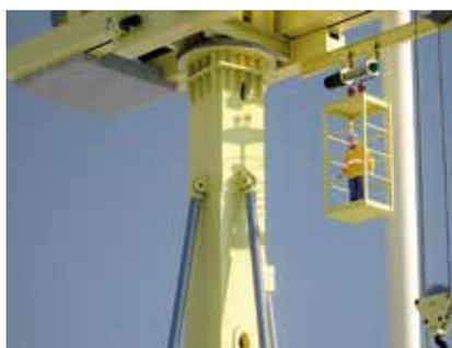
Entre sus productos destacan la grúa auto-trepante AirCRANE, capaz de construir cualquier torre de hormigón mientras asciende y termina montando el aerogenerador; AirTOWER, una solución patentada de secciones de torre de hormigón; y AirBASE, una solución ligera, modular, prefabricada de cimentaciones de aerogeneradores.
