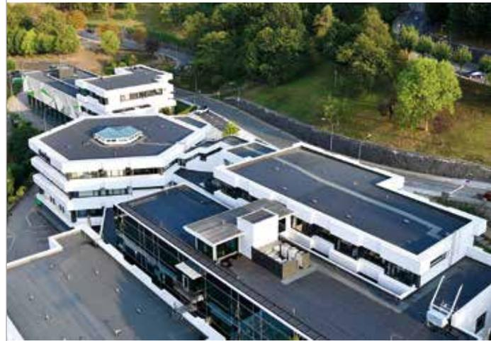
ULMA, ha sido la encargada de instalar la fachada ventilada, proporcionando soluciones técnicas que se ajustan a las geometrías complejas del edificio. Se han cubierto 6.220 metros cuadrados de fachada, integrando un sistema de fachada ventilada de hormigón polímero, que incluye aislamiento térmico y acústico, lo que ha permitido mejorar la clasificación energética del edificio.
